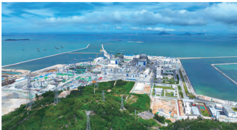
中核二四参建的“华龙一号”批量化首堆漳州核电现场
