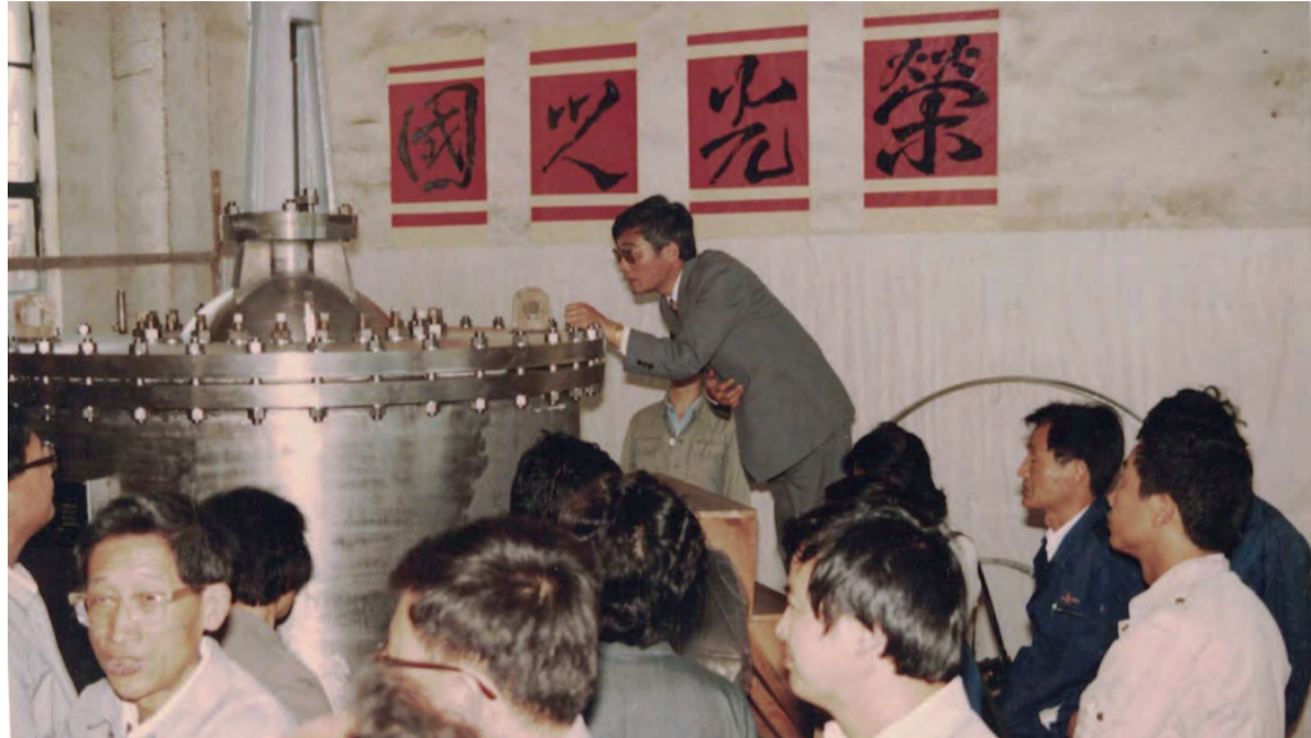
章果禹在500口径秦山核电地坑吨收现场
