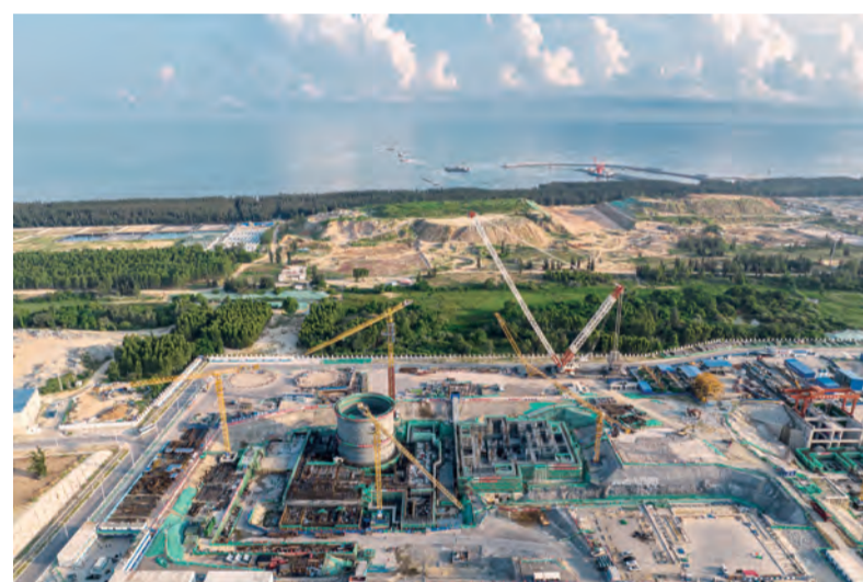
海南核电“玲龙一号”全球首堆核岛安装工程开工
